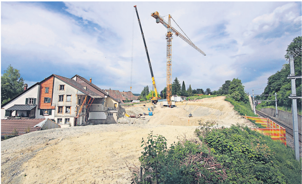
Am 20. Mai wurde der Kran mit einem 60-Meter-Ausleger gestellt, nun gehen die Bauarbeiten weiter.
