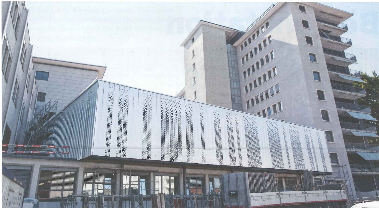
Blick von der Brunnengasse auf die Metallfassade des OP-Provisoriums. Es umfasst drei Säle und bildet mit den zwei «alten» Sälen des angrenzenden OP-Bereichs im Polikliniktrakt eine zusammenhängende Landschaft. Die erste Operation ist auf den 7. September angesetzt.
