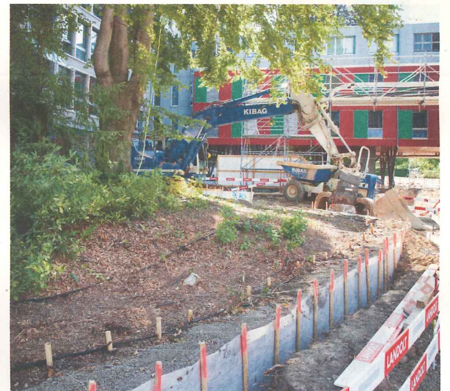
Eine aufwendige Wurzelbehandlung schützt die alten Bäume vor Bauschäden.
