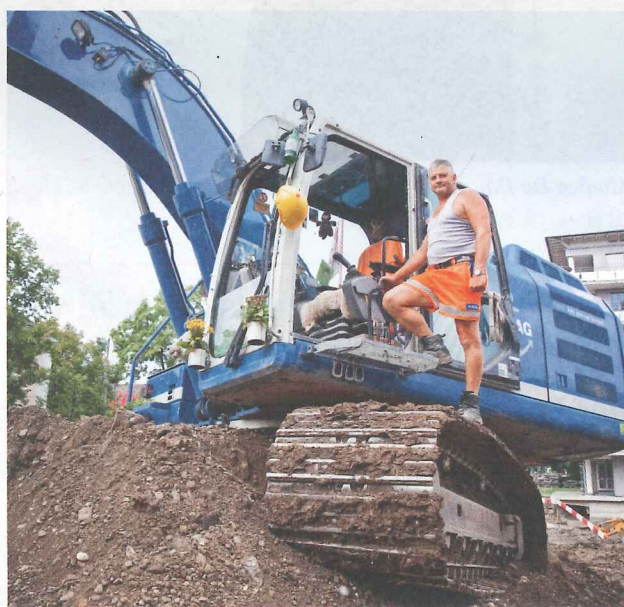
Baggerführer mit Sinn für Feinarbeit und Blumenschmuck.
