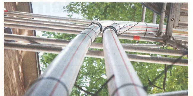
Während der Bauzeit führt die Rohrpost durch luftige Höhen.
